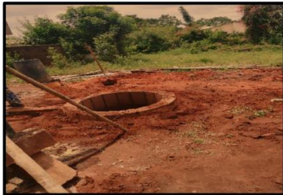
Quand le sol est mouvant, le revêtement se fait depuis le bas
