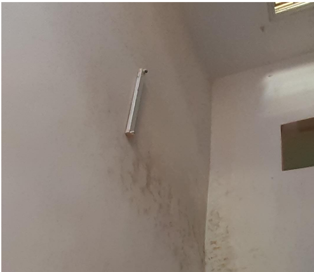
Photo : travaux d'étanchéités
