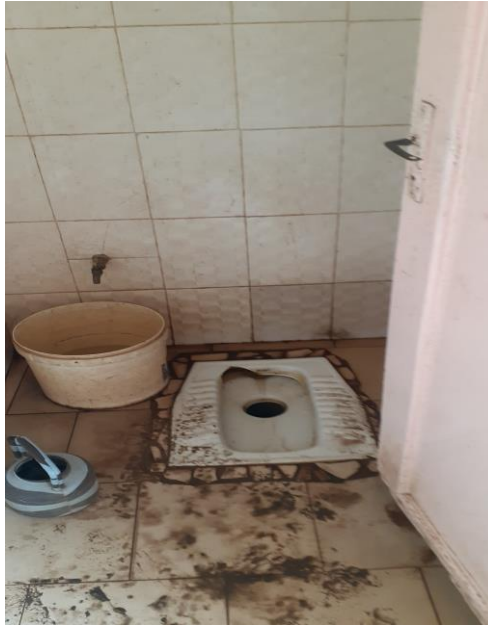
Photo : Vue sur revêtement sol des toilettes
