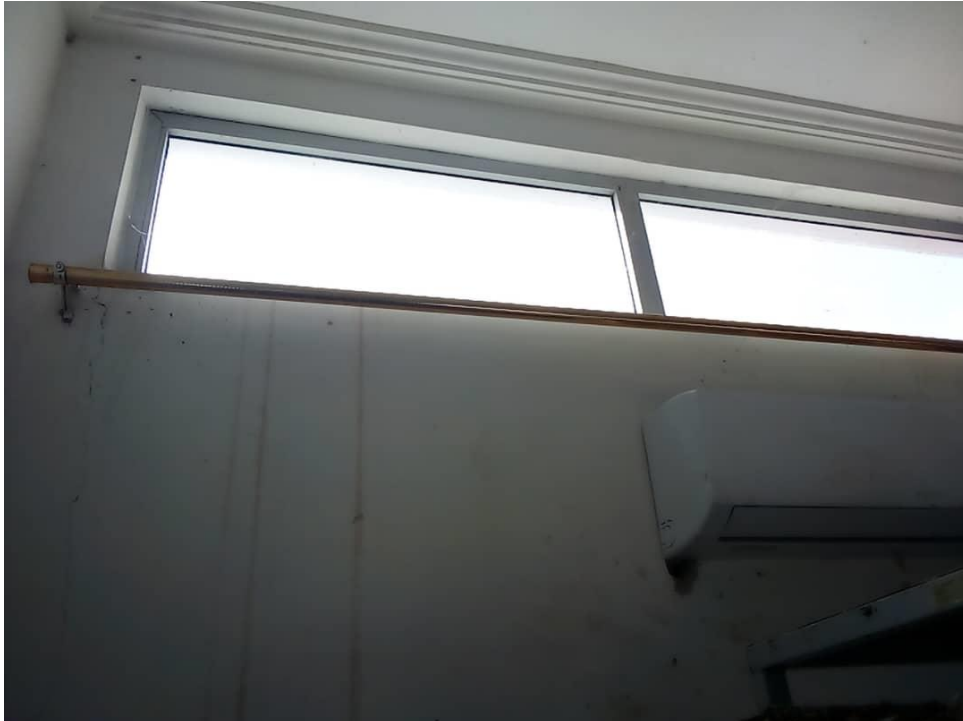
Photo Vue sur revêtement de la salle d'archive numéro1
