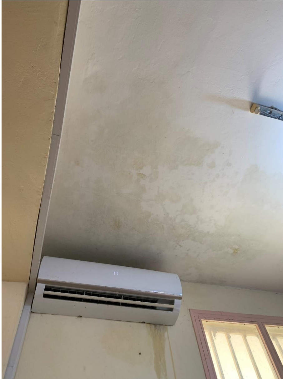
Photos Vue sur fissures existantes à corriger
