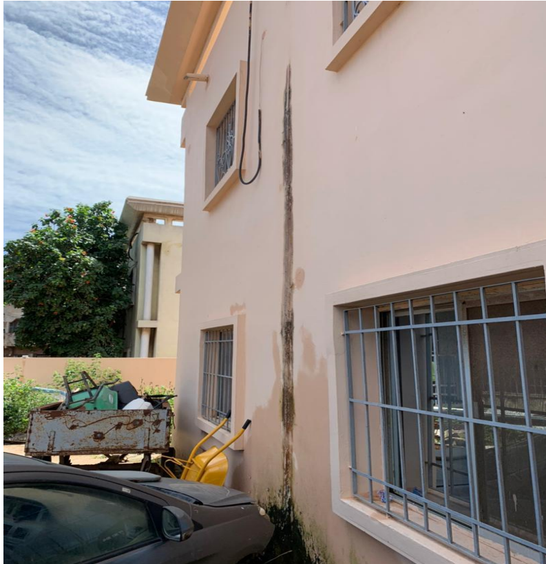
Photo Vue sur revêtement de la façade.
