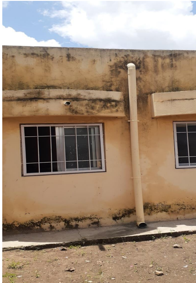
Photo: Vue sur revêtement de la façade.
