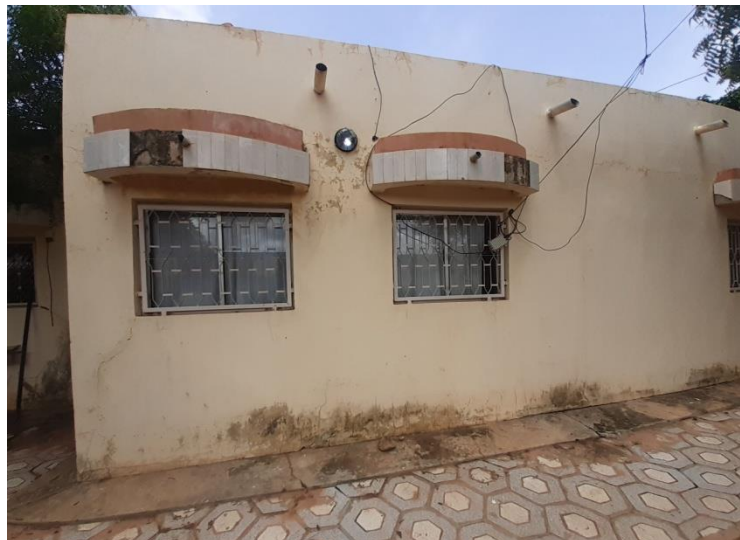
Photo : Vue sur fenêtre en bon état
