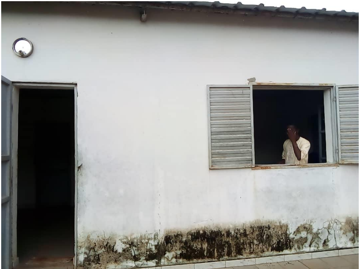
Photo : Vue sur revêtement de la façade de la salle d'archive n2.
