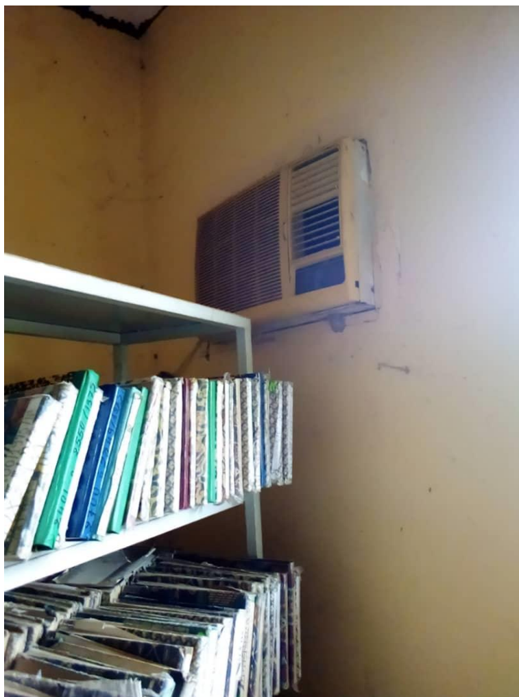
Photo Vue sur revêtement de la salle d'archive numéro2
