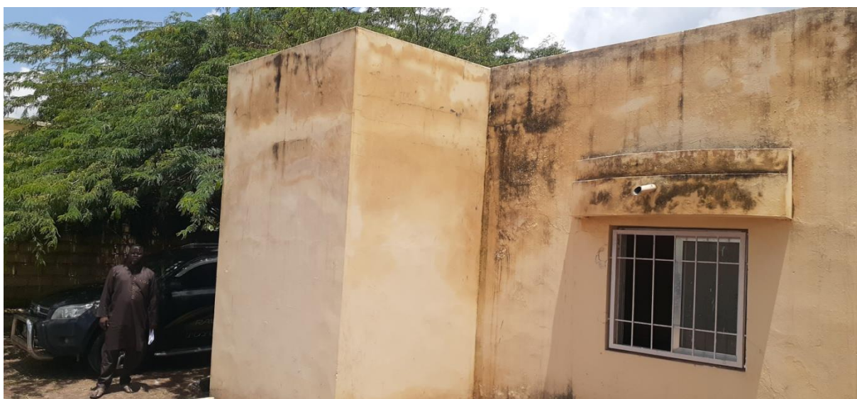
Photos: Vue sur le mur état de la peinture
