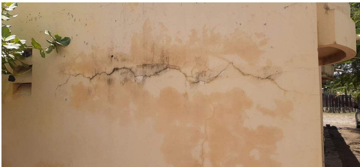
Photo : travaux d'étanchéités
