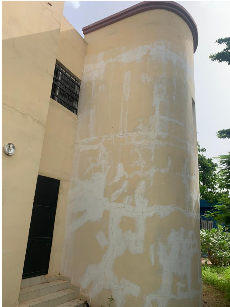
Photo 7 : Vue sur revêtement de la façade.
