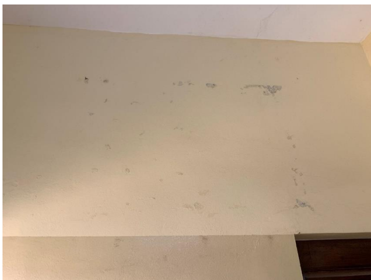
Photos Vue sur le mur état de la peinture
