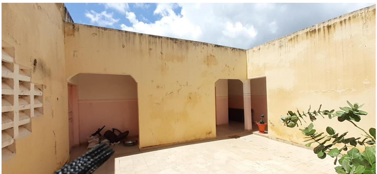
Photo : Vue sur revêtement de la façade.
