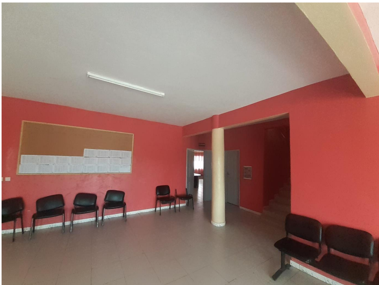
Photo : l'état du bâtiment ne montrant pas de dégradation
