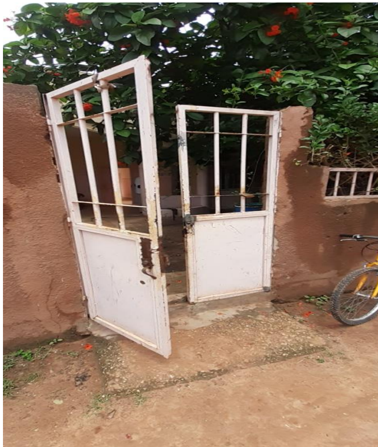
Photo : Vue sur les menuiseries extérieures et intérieures existantes
