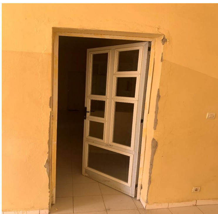
Photos : Vue sur les menuiseries extérieures et intérieures existantes.
