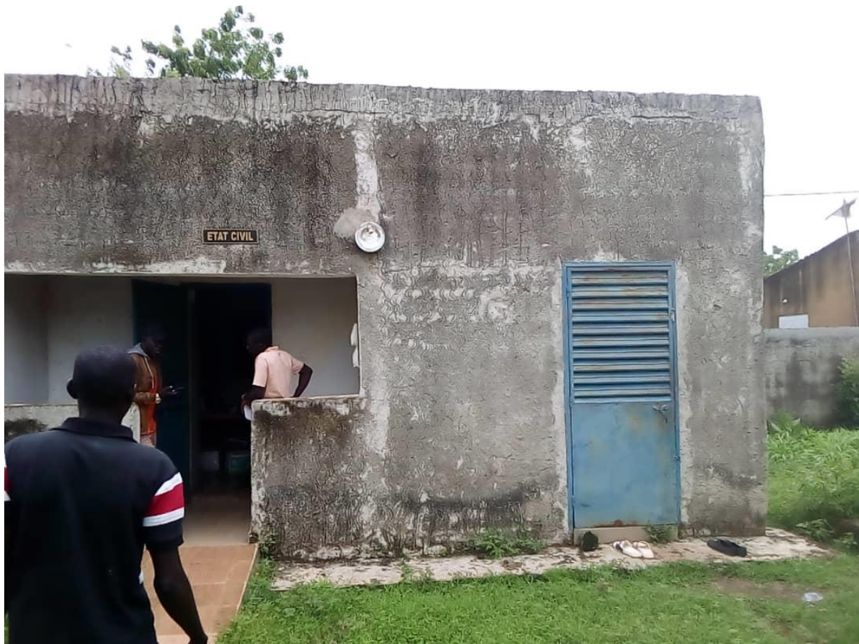
Photo Vue sur l'extension de l'état civil abritant la salle d'archive.
