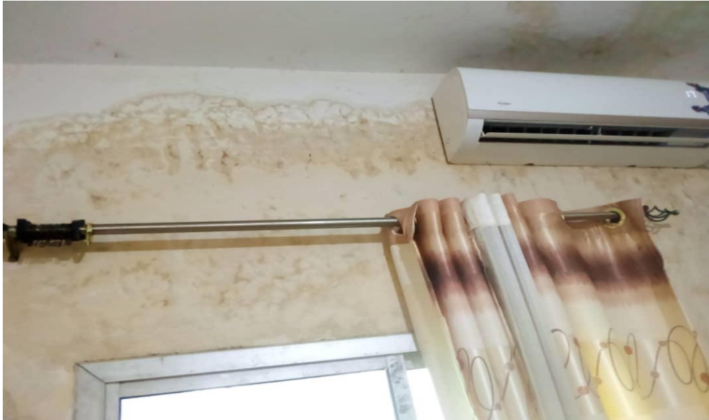
Photos Vue sur le mur état de la peinture
