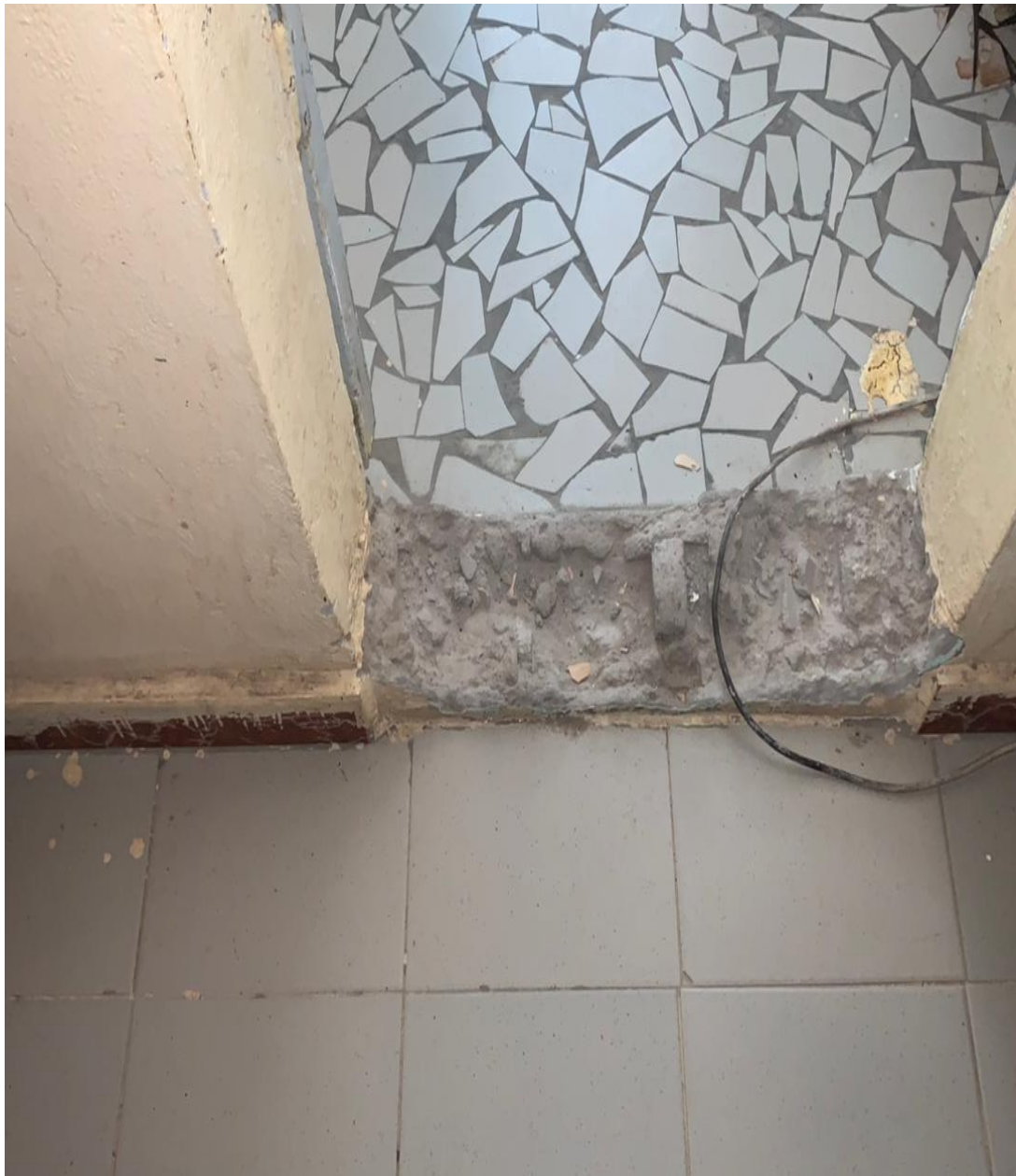
Photo Vue sur le revêtement du sol existant
