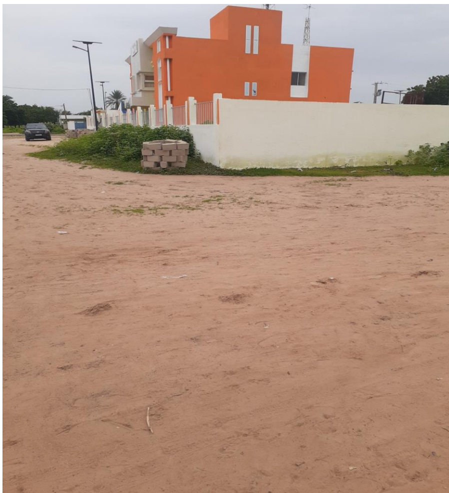
Photo : Vue de loin de la structure en bon état
