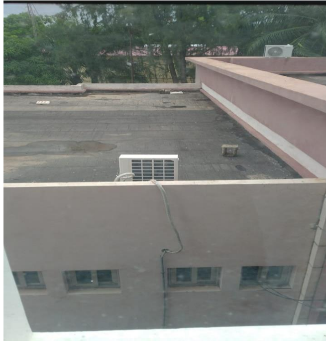
Photo Vue sur l'étanchéité sur le toit
