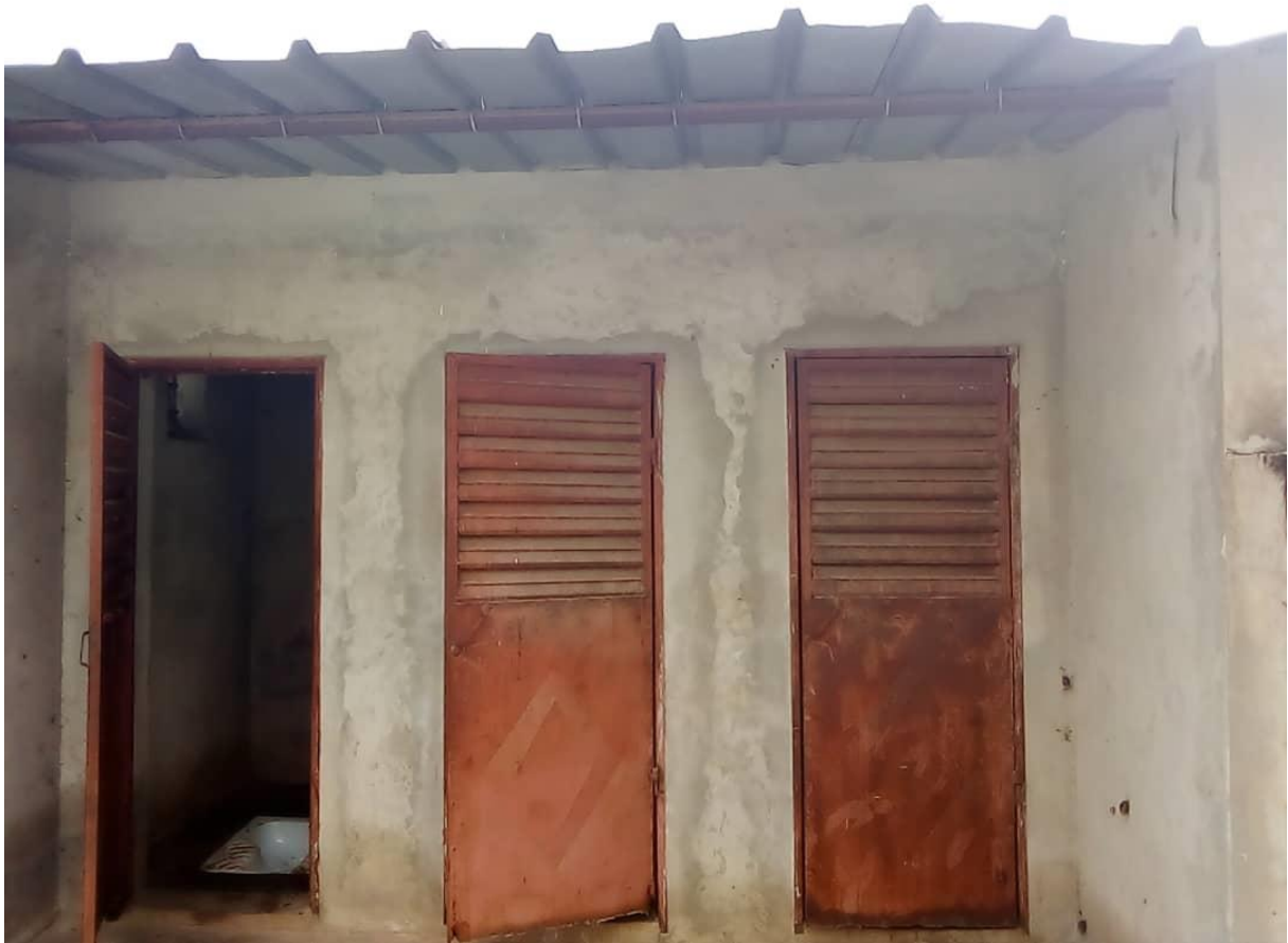
Photo Vue sur toilettes secondaires non équipée
