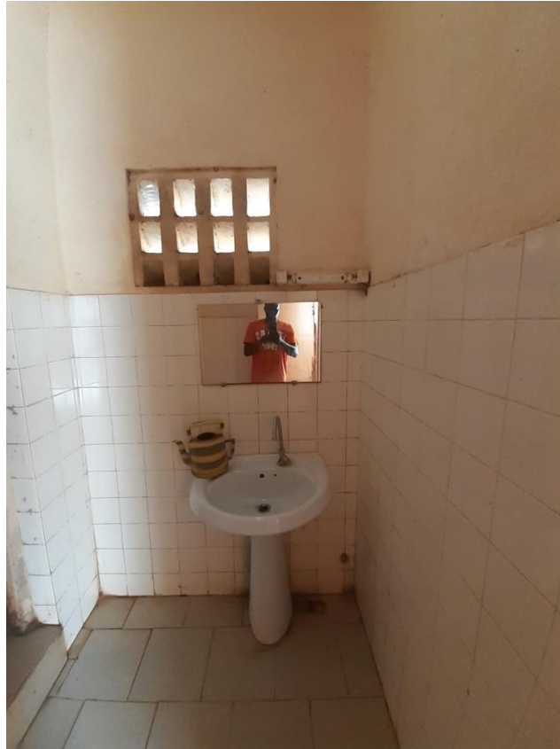
Photo : Vue sur imposte toilette à changer en fenêtre 60/100.
