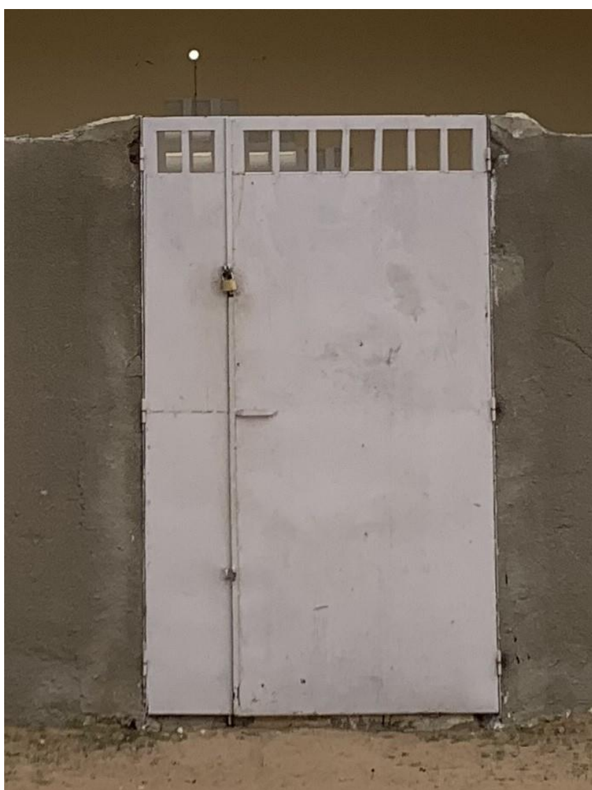
Photos 9 : Vue sur les menuiseries extérieures et intérieures existantes.
