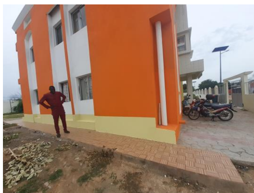
Photo : vue sur l'emplacement choisi pour le nouveau bâtiment en RDC
