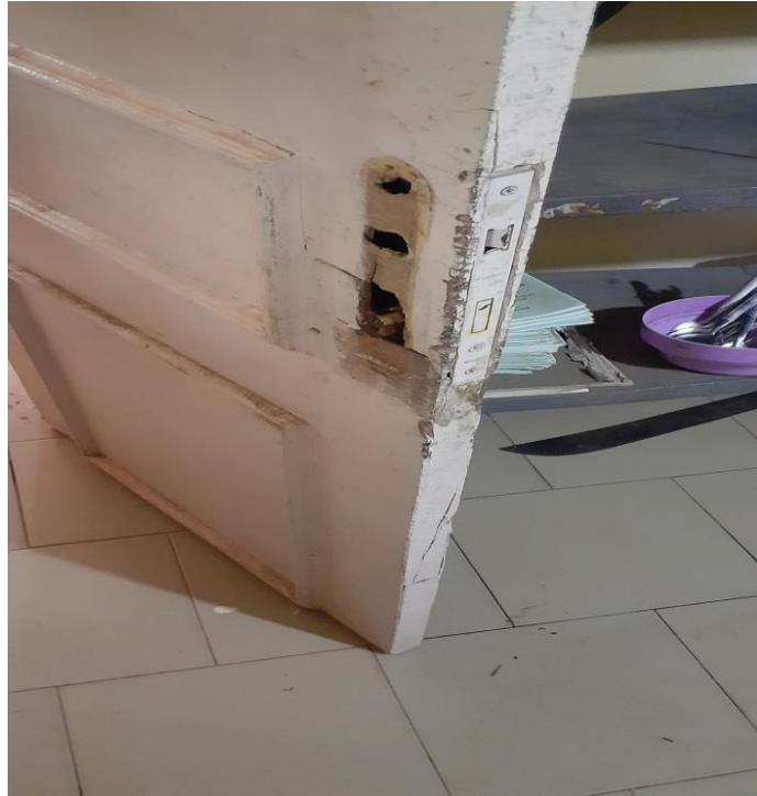
Photos11': Vue sur les menuiseries extérieures et intérieures existantes
