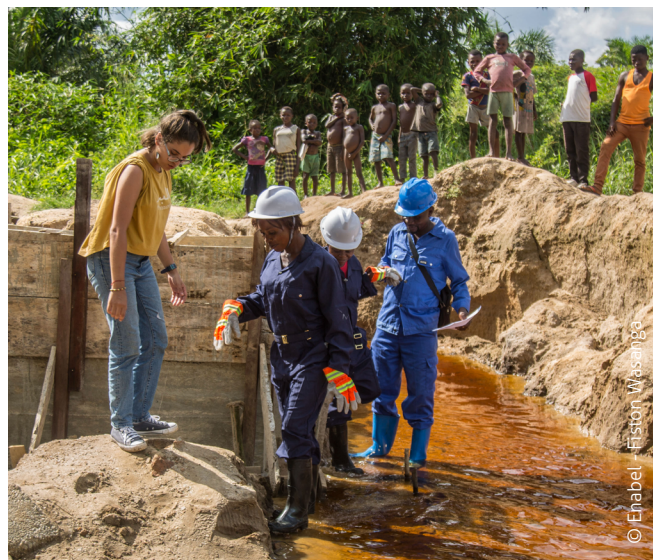
↑ Visite du pont en construction à Yanonge, Tshopo
