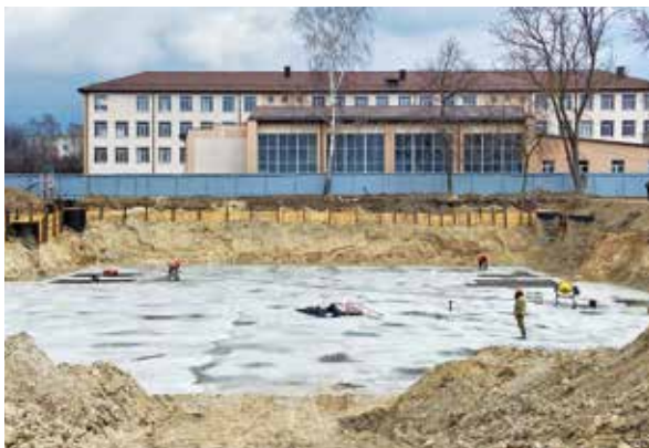
Bouw van een schuilplaats in Baryshivka in de regio Kiev. © Enabel
