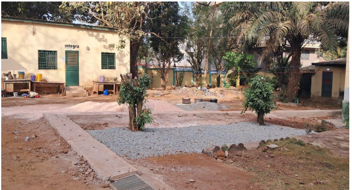
État actuel d'une partie de la cour à réaménager
