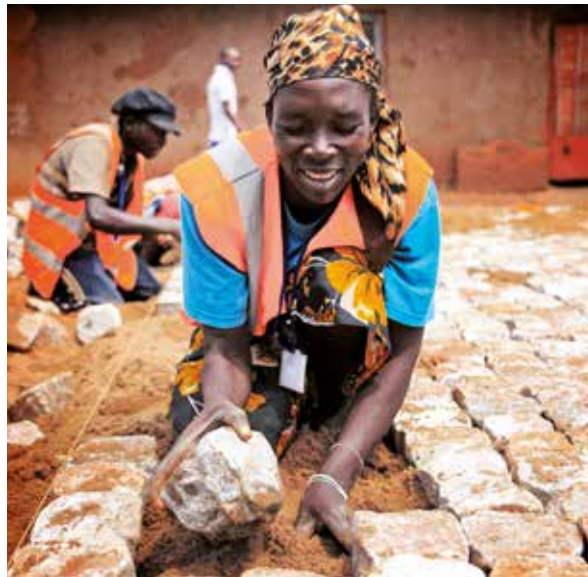
Bujumbura: Kasseiwegen zijn gemakkelijker in onderhoud en duurzamer dan asfalt- of betonwegen. © BTC / Rosalie Colfs
