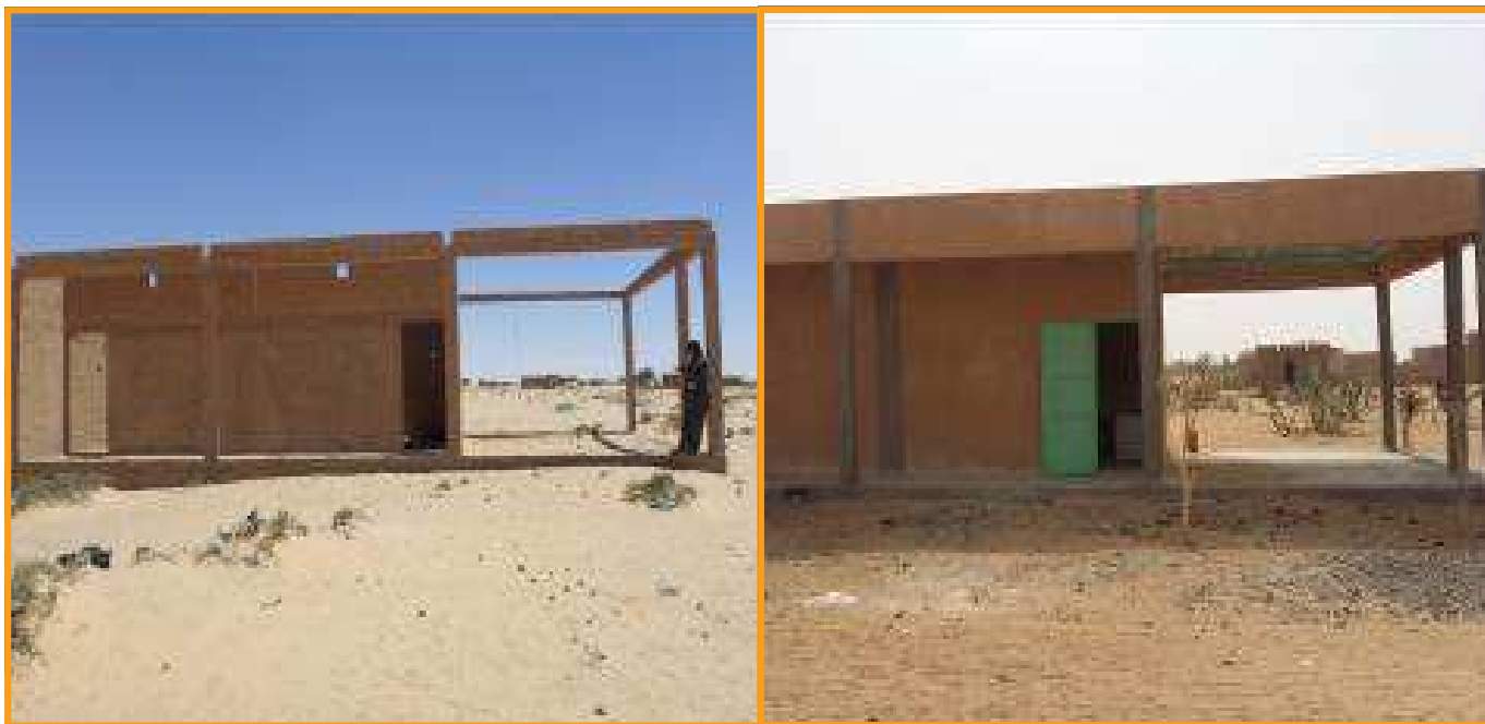
Case de santé vétérinaire de Tounfaminir. Avant et après réhabilitation par le projet
